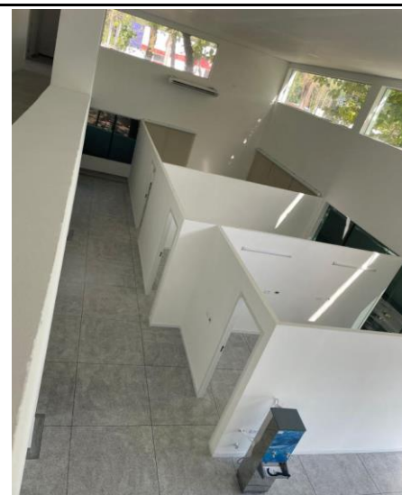
FOTO 09- VISTA INTERNA ESCRITÓRIO COM FECHAMENTO DRYWALL
