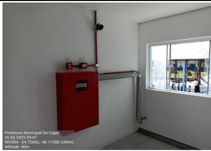
FOTO 16- ABRIGO DE MANGUEIRA E SISTEMA DE ALARME
