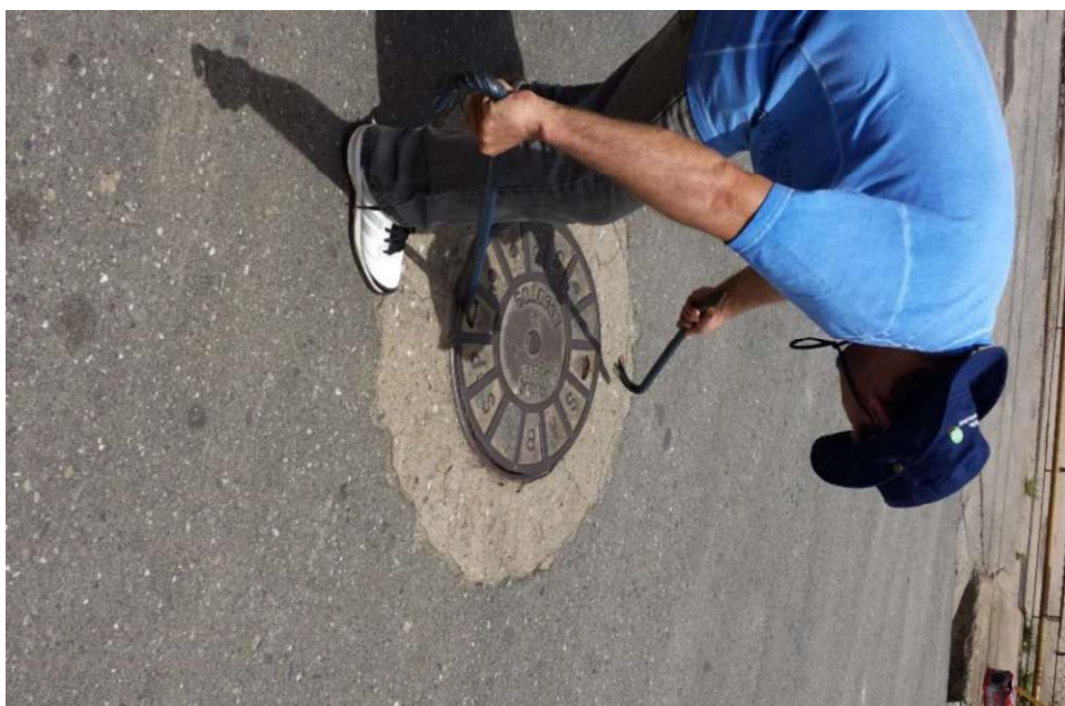
Foto de abertura de poço de visita de esgoto
