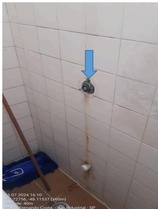
Válvula Hidra aparente sem função.
