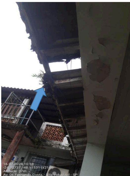
Cobertura com partes do telhado faltantes.
