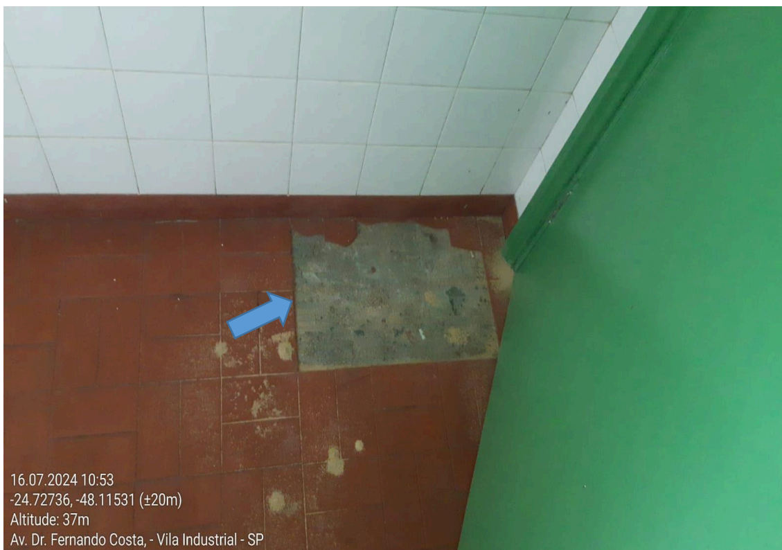
Piso destacando.
