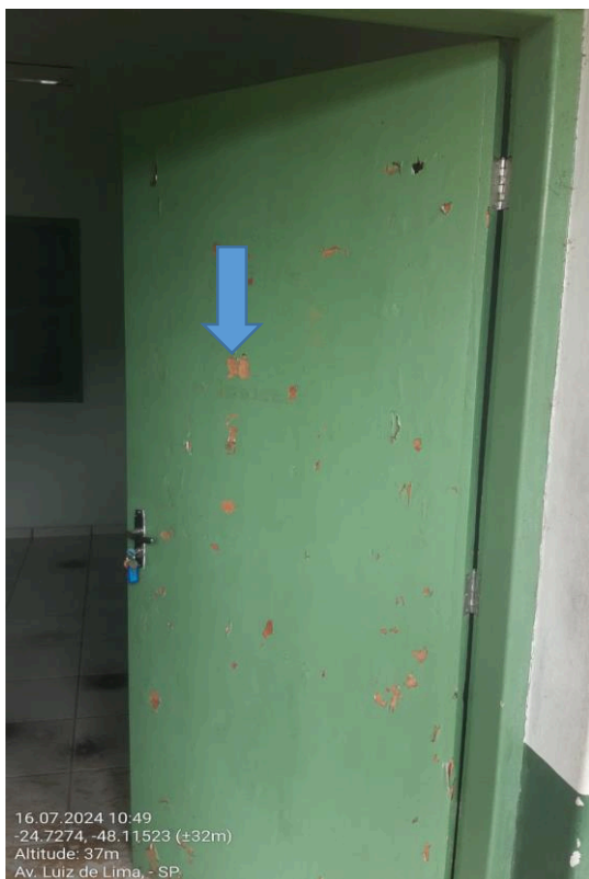
Porta deteriorada pela ação do cupim. Rampa de acesso a sala.
