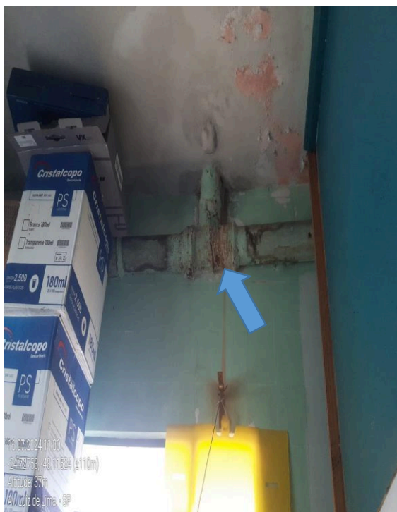
Edificação com instalação hidráulica antiga, tubulação de ferro.
