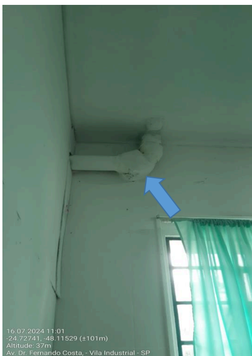
Edificação com instalação hidráulica antiga, tubulação de ferro.
