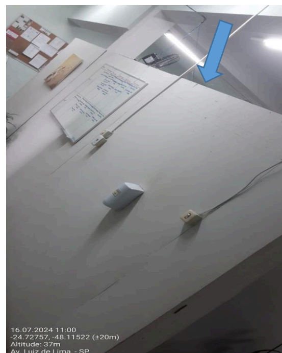
Divisão das salas feitas com tapume
