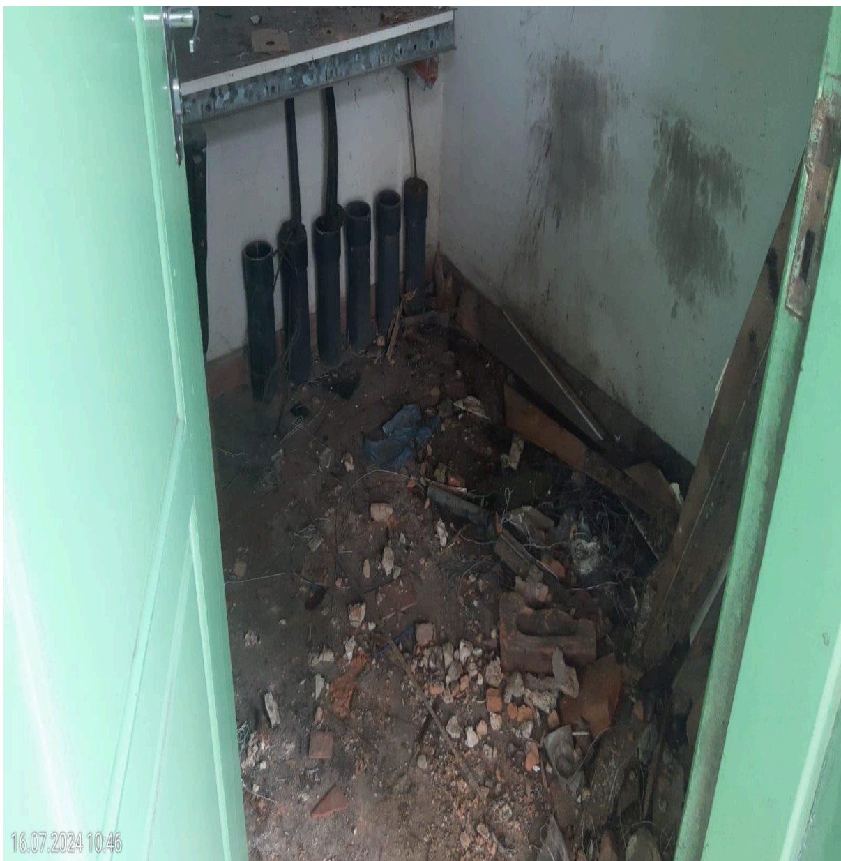
Sala com telhado, forro e elétrica e dados aparente.
