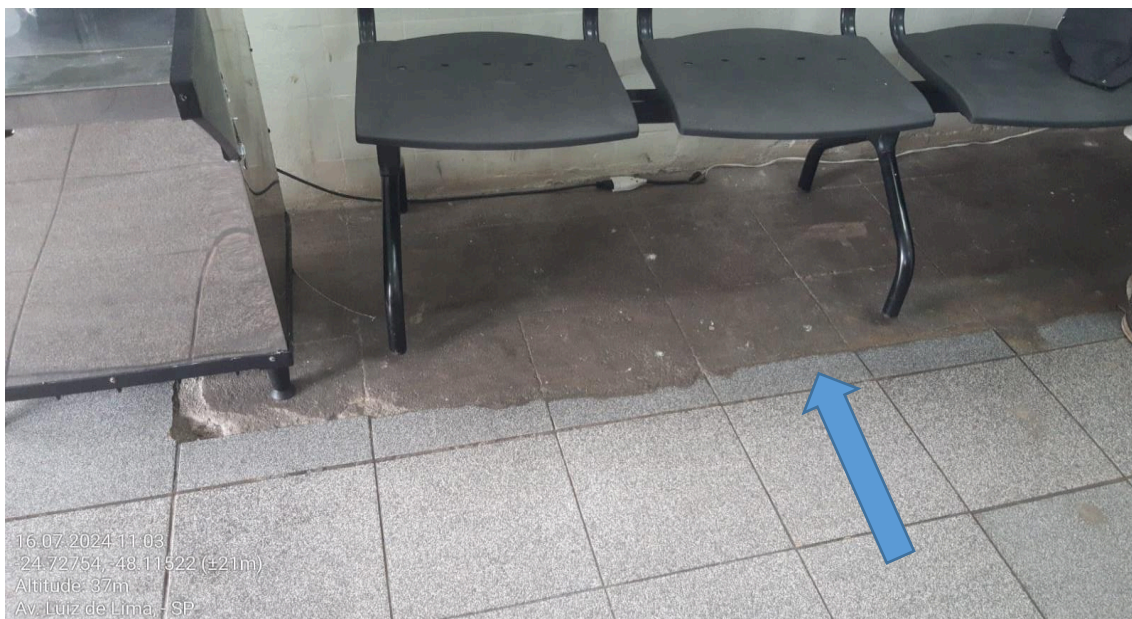
Acesso com reparos e adequações
