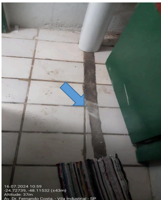
Reparo de Instalação hidráulica.
