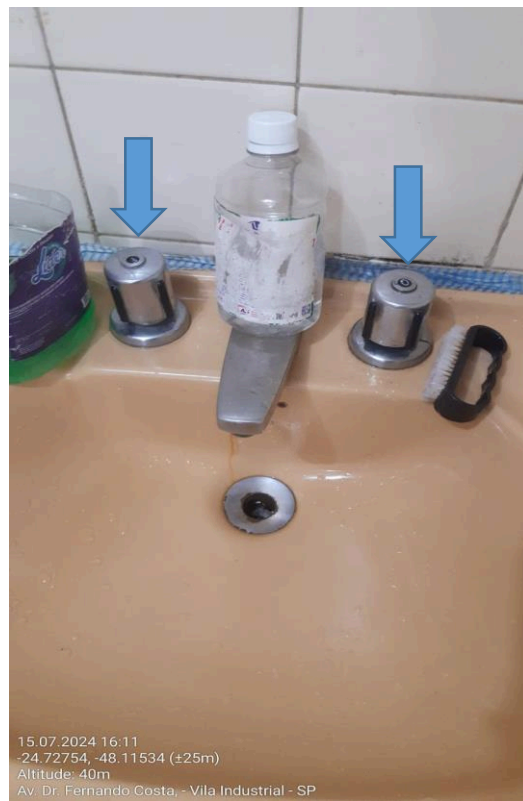
Vaso sanitário e lavatório com peças antigas e com vazamento.
