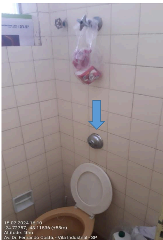
Vaso sanitário e lavatório com peças antigas e com vazamento.
