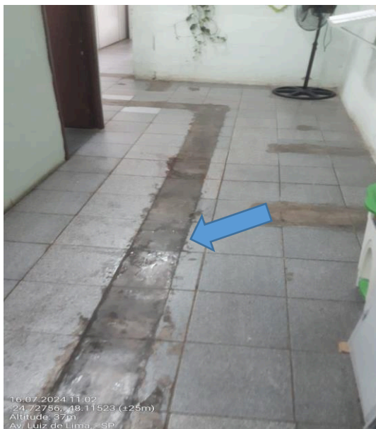
Reparo no piso.
