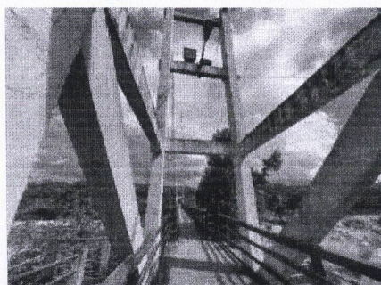
c) Estrutura de sustentação da ponte.
