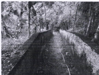
b) Acesso a ponte através de escadaria.
