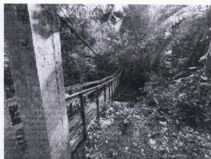
b) visão geral da ponte.
