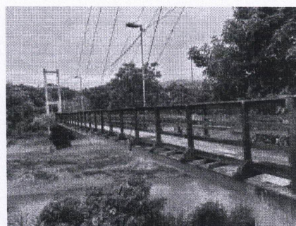
d) Visão geral da ponte.
