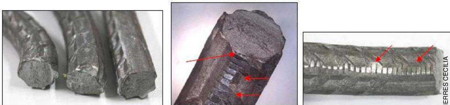
Detalhe das extremidades dos vergalhões apresentando fratura frágil associado a marcas mecânicas .
