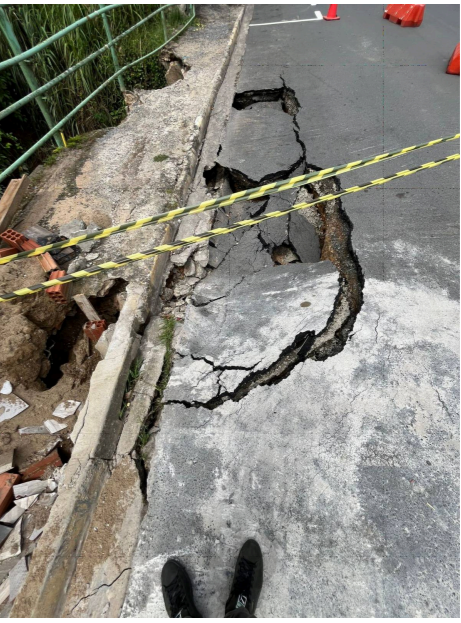
IMAGEM: SITUAÇÃO DO PAVIMENTO
