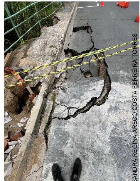
IMAGEM: SITUAÇÃO DO PAVIMENTO
