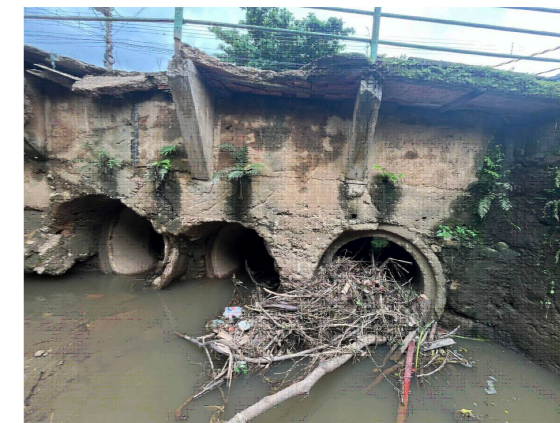
IMAGEM: SITUAÇÃO DA ALA EXISTENTE
