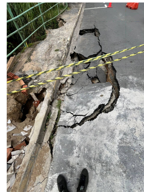
IMAGEM: SITUAÇÃO DO PAVIMENTO
